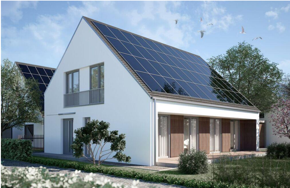
Bild 3_Einfamilienhaus_EFH Plus Hugelshart.
